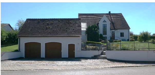
Dr.-Johann-Baptist-Kurz-Platz 8: Eingeschossiges Wohnhaus mit steilem Satteldach und Zwerchhaus, vom Straßenraum zurückgesetzt, an der Straße traufseitig ein größerer Garagenbau, alle Dächer mit Biberschwanzdeckung
