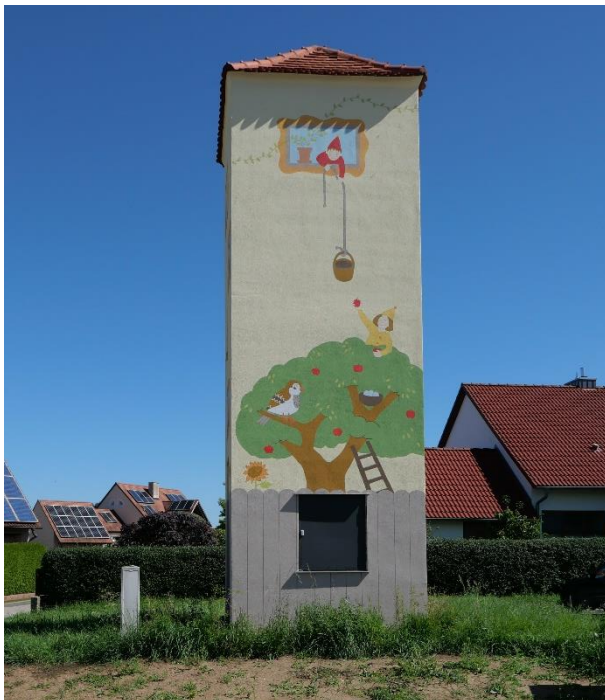
Seitenstraße, FlNr. 589 Transformatorhaus, vertikaler Bautyp aus der Ära der Freileitungen mit regionaltypischem Zelt-dach, Biberschwanzdeckung, im Zuge der Anlage der Kindertagesstätte bemalt
