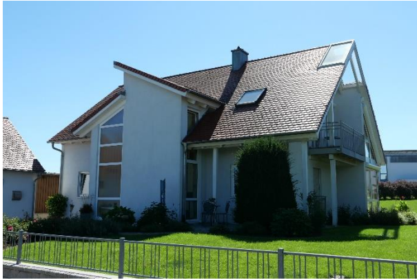
Seitenstraße 8: Eingeschossiges Wohnhaus mit steilem Satteldach und Biberschwanzdeckung in einer Mischung aus traditionellen Bauformen und modernen Elementen wie beispielsweise die Zwerchhäuser
